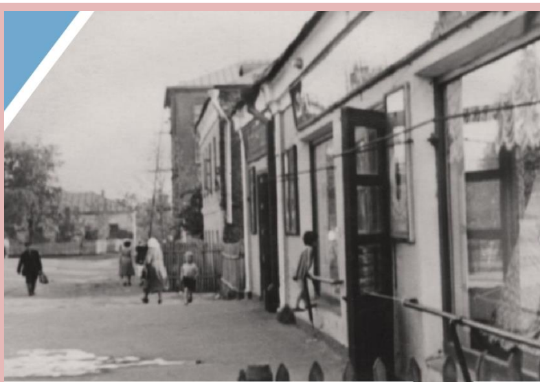
Здание Слесарской и фабричного магазина Ул. Ашхабадская (бывшая ул. Вокзальная)
