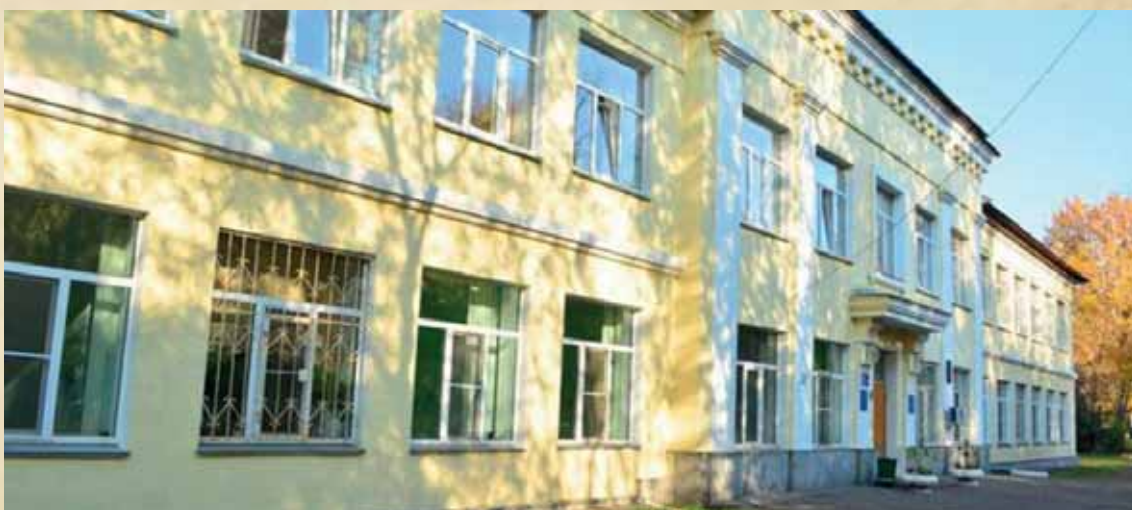
Главный вход, сохранивший особенности архитектуры
