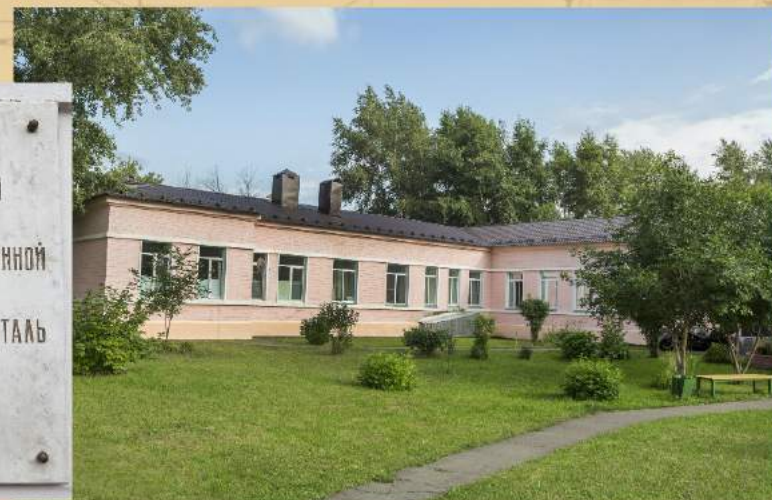
В 1950-60-е годы здания были перестроены.
