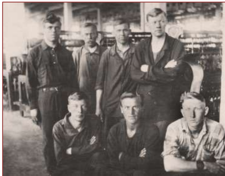
1925 ГОД. БРИГАДА ПО РЕМОНТУ ЭЛЕКТРООБОРУДОВАНИЯ.
